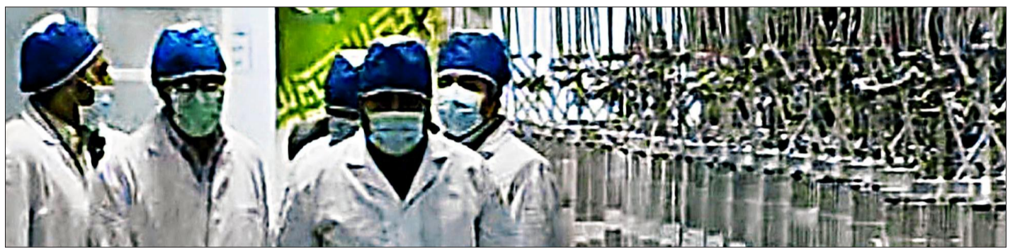
Nur friedliche Absichten? Zentrifugen zur Urananreicherung in iranischer Atomanlage von Natans
